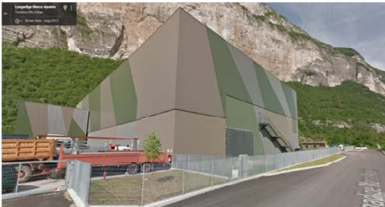
Figura 8: Immagine illustrativa degli edifici che compongono l'impianto della società SATIVA in località Laghetti della Vela. (FONTE - Google maps - marzo 2016)
