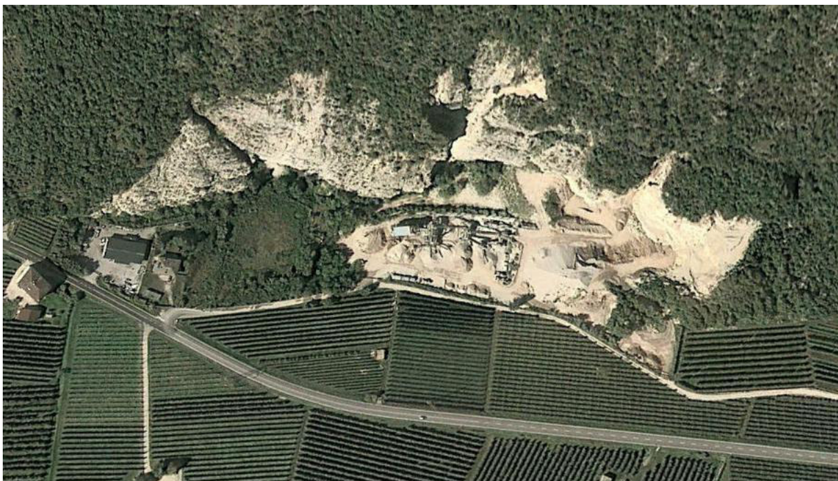
Vista satellitare della cava e impianto in esercizio destinati alla riconversione progettuale
