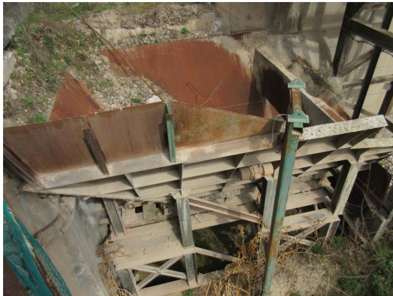
Figura 21: stazione di valle della teleferica, particolare della tramoggia di carico
