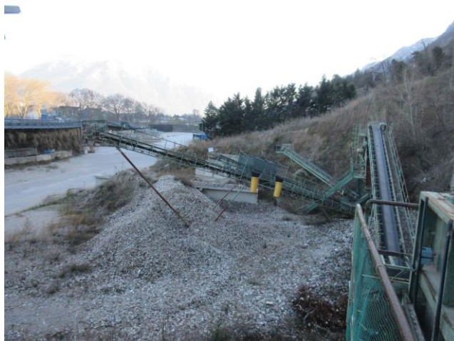
Figura 17: Sistema di vagliatura che verrà smantellato per lasciare posto alle aree di stoccaggio
