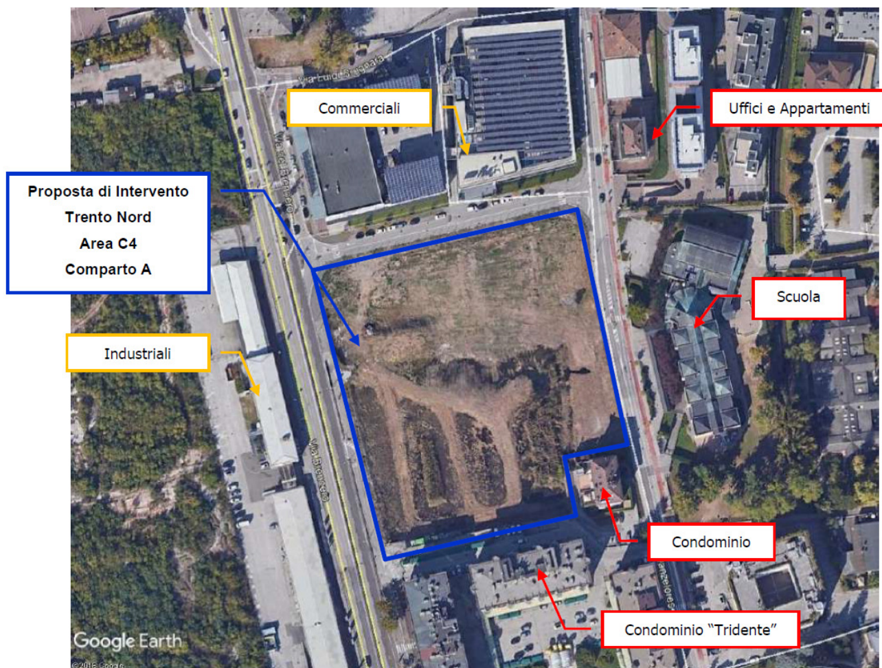
Figura 29: Inquadramento del sito rispetto alla attività/costruzioni circostanti. (FONTE: Relazione PRO.TECNO S.r.l - 30.10.2019)
