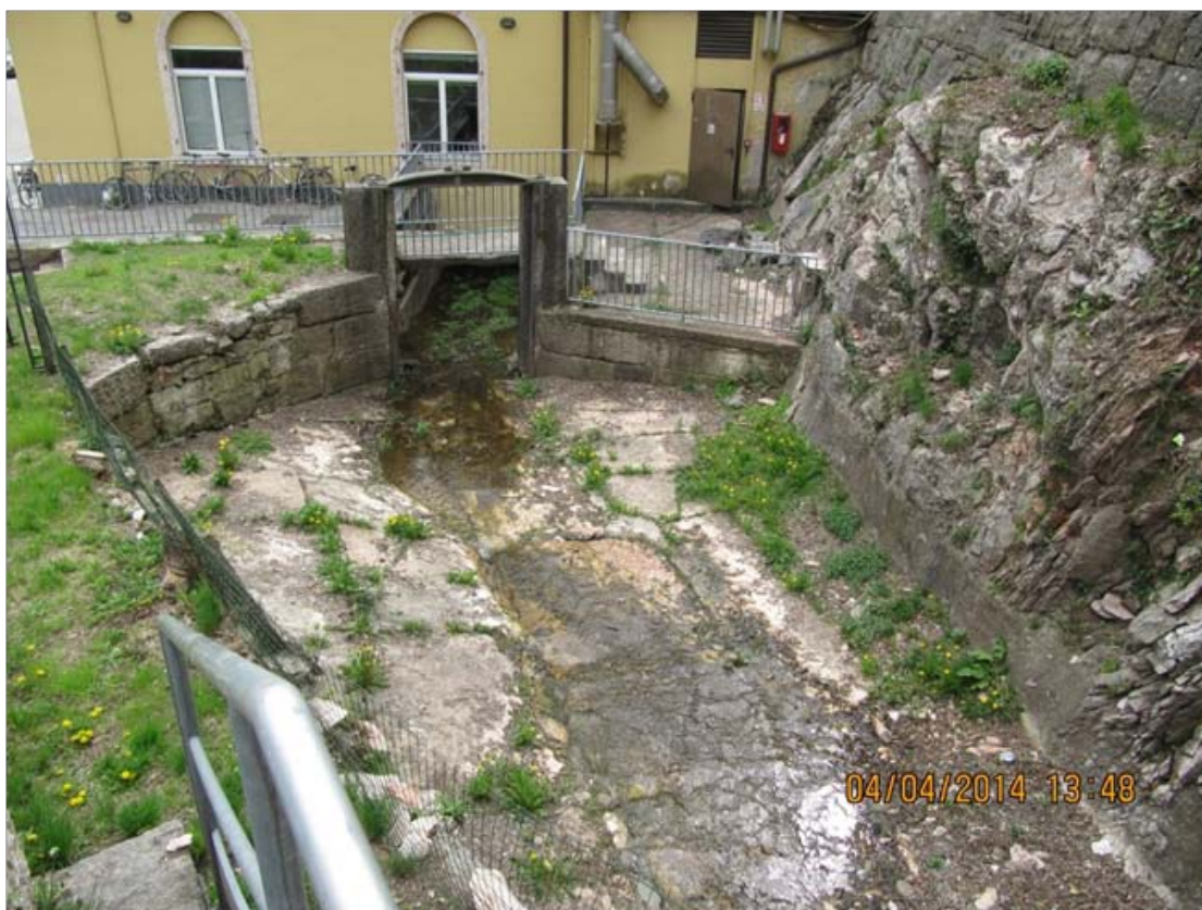
Figura 8 - Vasca di calma esistente a servizio della roggia del Bollione (o roggia Grande).
