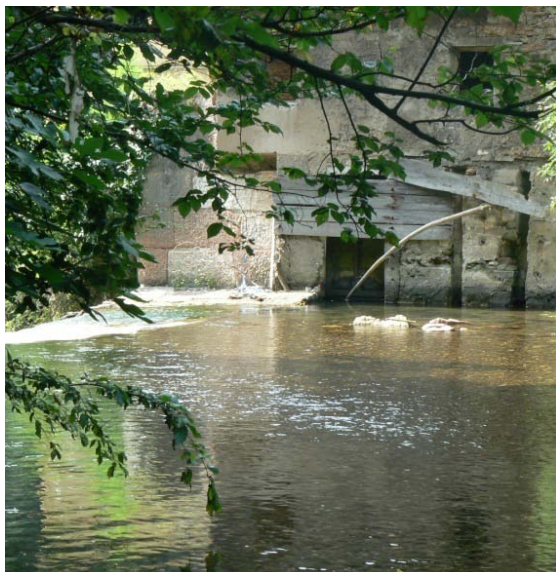
Figura 4 - Opera di presa esistente – vista da sponda sinistra Fersina .
