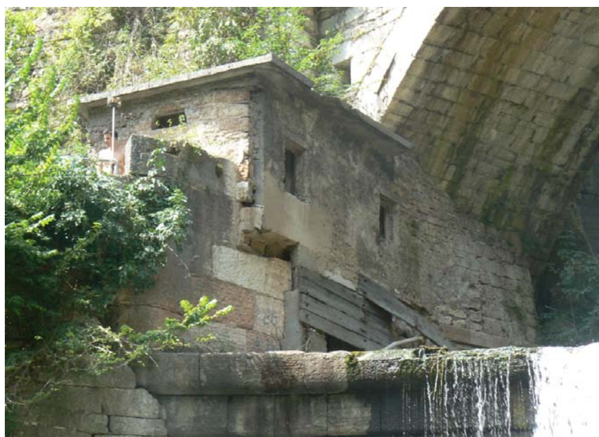
Figura 10 - Torretta di presidio da demolire.
