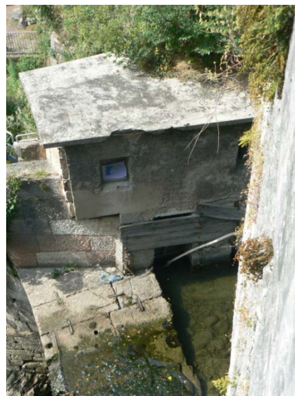
Figura 5 - Opera di presa esistente – vista da ponte Cornicchio.
