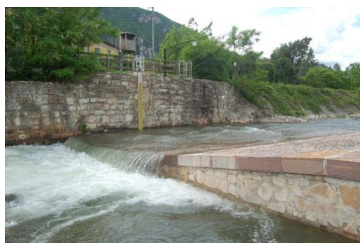
Figura 35 - Stazione di misura Fersina Trento, gestita dall'Ufficio Dighe – Provincia di Trento. A sinistra la posizione relativa rispetto al ponte Cornicchio
