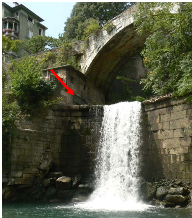
Figura 15 – Ponte Cornicchio e opera di presa - vista da valle.
