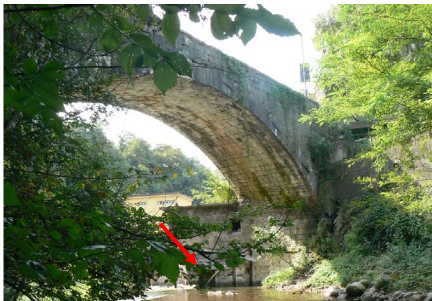
Figura 16 – Ponte Cornicchio e opera di presa - vista da sponda sinistra.
