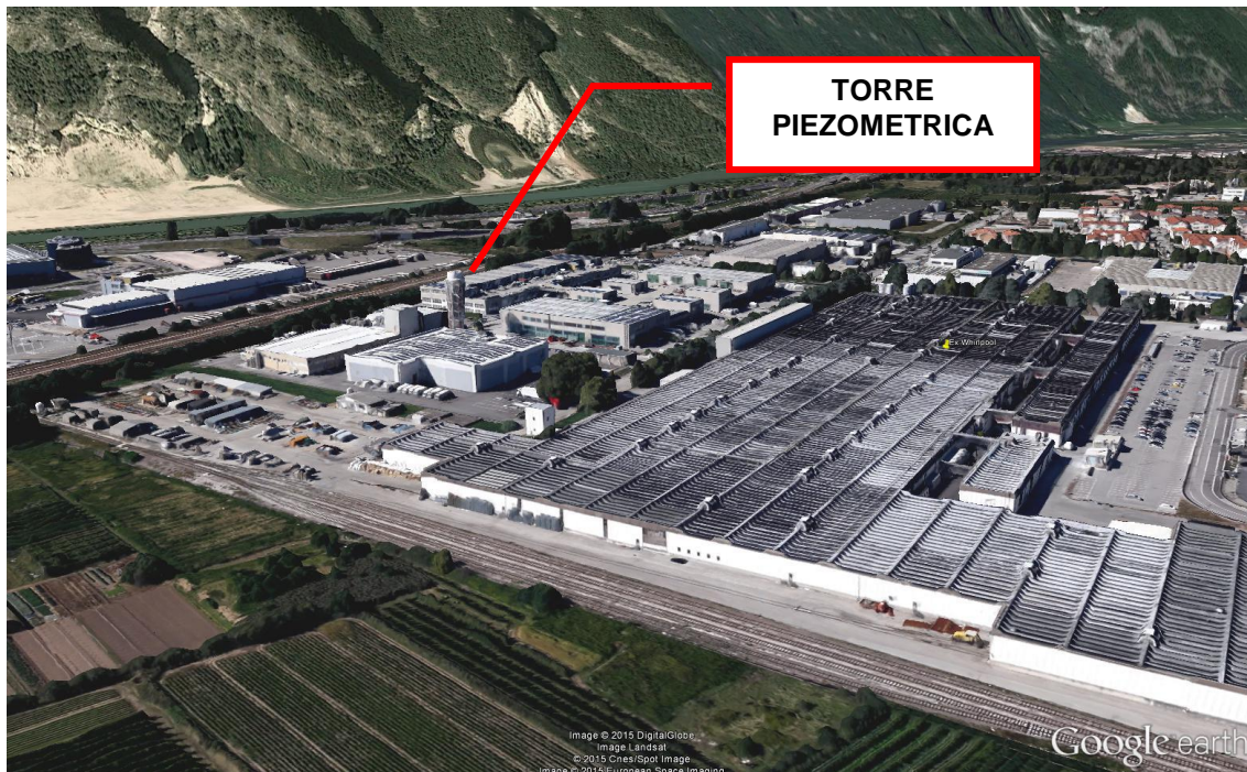
Figura 10: immagine con indicata la torre piezometrica del vicino stabilimento Trentingrana.
