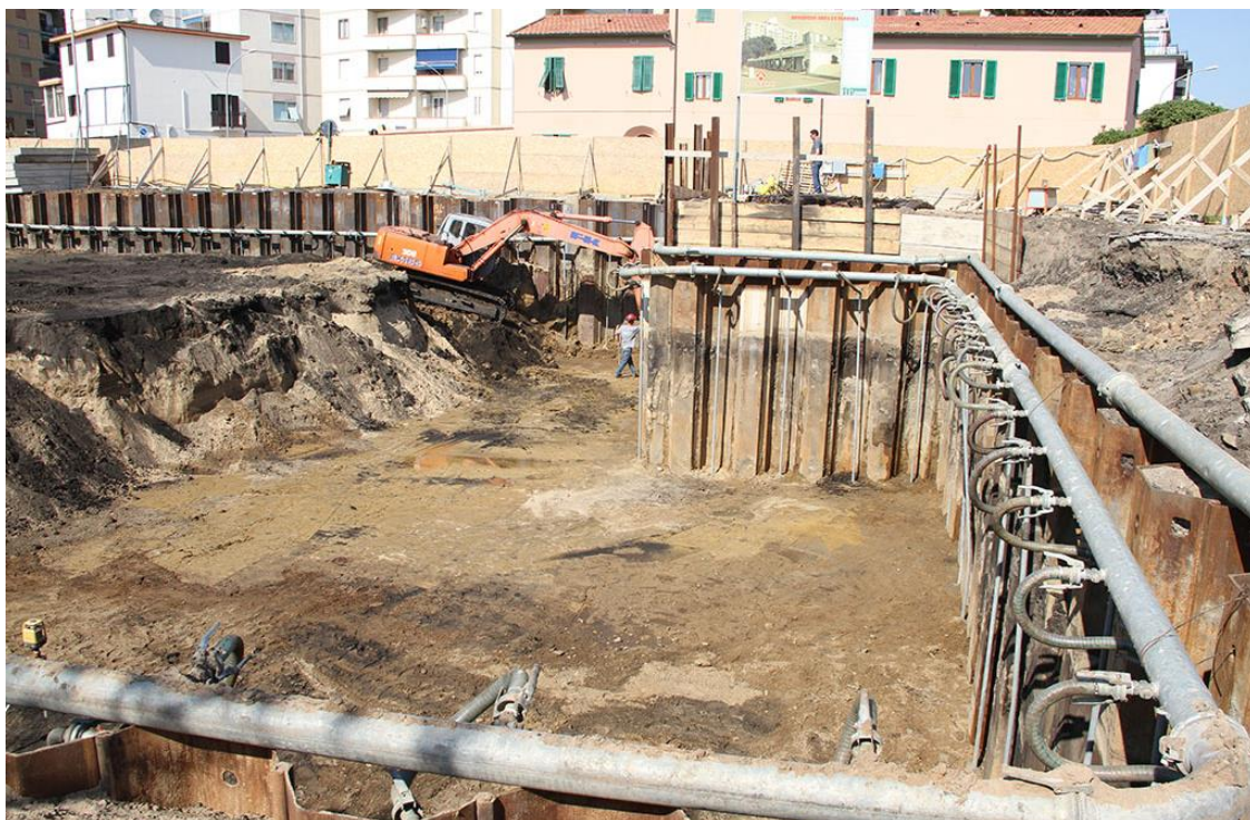
Figura 18: cantiere con attivato un sistema di pompaggio dell'acqua di falda.
