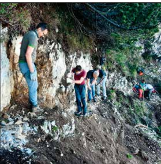
Lavori di sistemazione del sentiero 447 sulla Vigolana.
