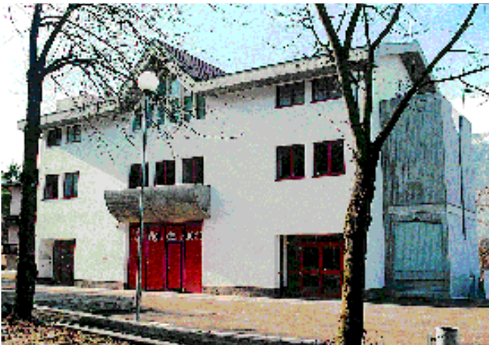
Nuovo centro Civico - Baselga del Bondone
