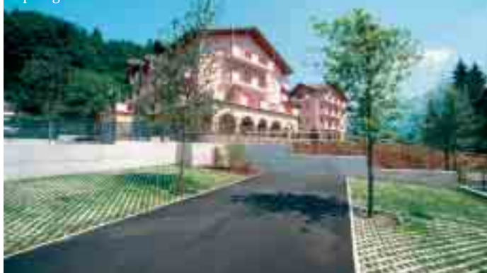
RSA di Montagnaga di Pinè tipologia di costruzione
