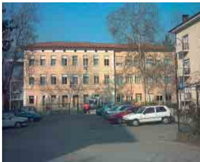
Scuola elementare di Sopramonte
