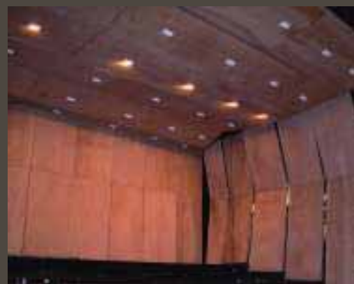
La camera acustica in fase di montaggio
