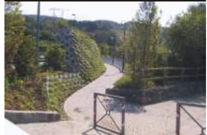
Percorso pedonale Ravina
