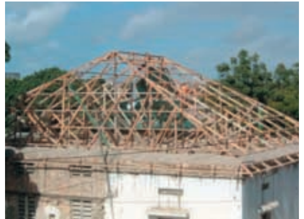
L'edificio scolastico durante la ristrutturazione
