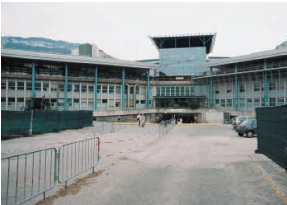
I lavori di ristrutturazione dell'ospedale S. Chiara (New Photo)
