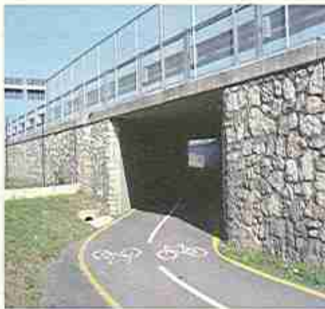
Ultimati i lavori del collegamento ciclopedonale a cavallo della tangenziale Sud (Via Fersina)
