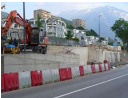
I lavori per la rinnovata fermata dell'auto-bus in Viale Verona (fronte ASL).
