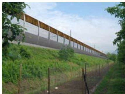
Anche in Clarina verranno collocate le barriere antirumore lungo la ferrovia.
