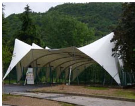
La nuova tensostruttura di Villazzano Tre.
