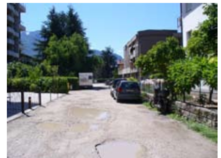
Lavori in vista per l'asfaltatura delle strade laterali di via Degasperi.
