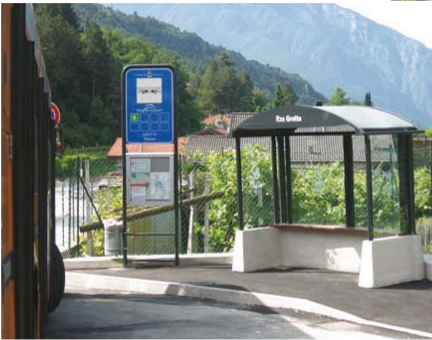
Pensilina fermata autobus linea n°6 Località alla Grotta
