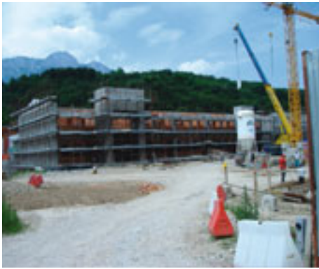
Le scuole di Cadine in costruzione
