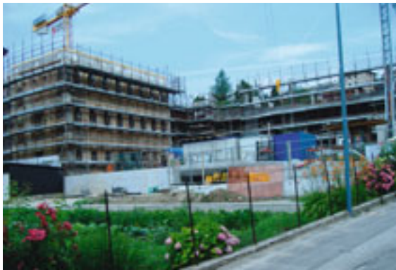
La scuola di Sopramonte in costruzione
