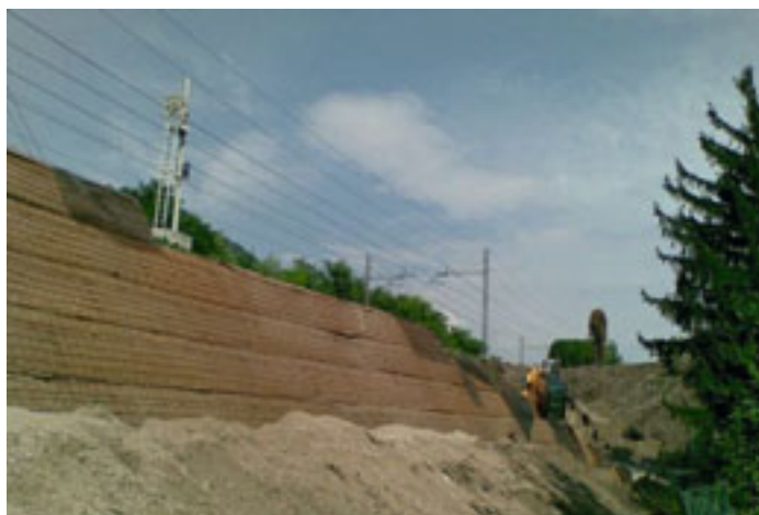
Via dei Muredei barriera anti-rumore su ferrovia Verona-Brennero.
