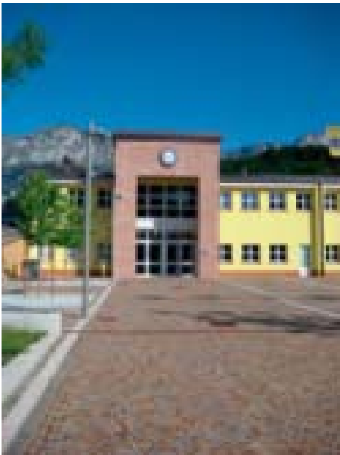
Ingresso della nuova scuola
