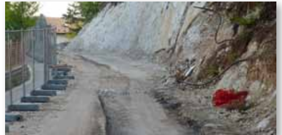
Rettifica della strada in via alla Pellegrina a Cognola
