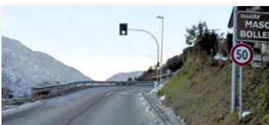
Semaforo a Maso Bolleri a Martignano visto da sud
