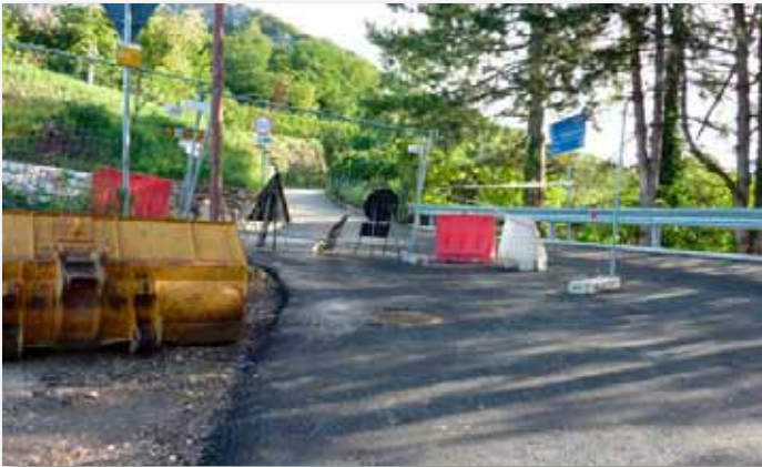
Sistemazione strade in via Bergamini
