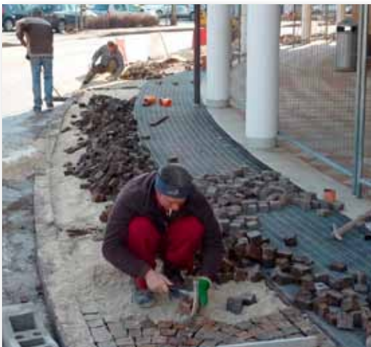
Rifacimento dei marciapiedi al Centro Civico di Cognola
