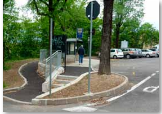
Completamente rinnovati l'accesso alla pensilina e l'area di attesa autobus in zona Laste
