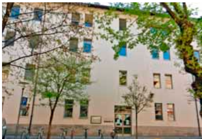
Edificio di via Bronzetti, futura sede della Circoscrizione
