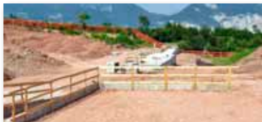
Base in cemento dei nuovi spalti del campo da calcio di Martignano
