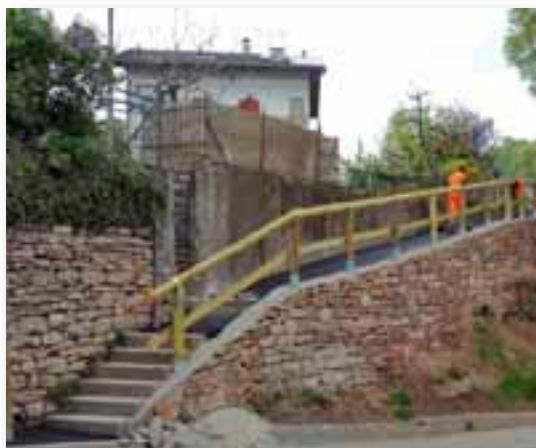
Completamente rifatta la scala che immette su via Marnighe a Cognola
