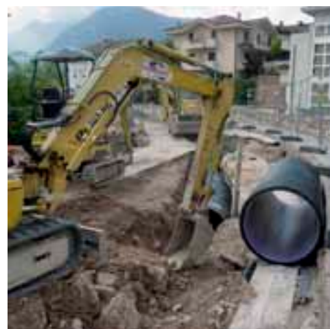
Rifatte completamente le condutture delle acque bianche in prossimità del civico 42 di via Alle Coste, in prossimità di via Bassano
