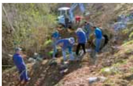
Argentario Day 2012: Uomini e mezzi per ripristinare il passaggio su di una vecchia strada comunale a Montevaccino
