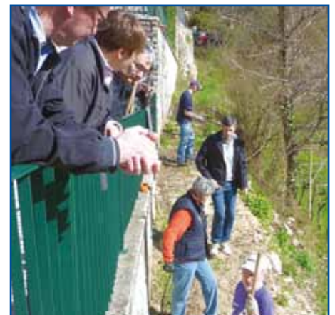
Il Sindaco accompagnato da tre assessori osserva i complessi lavori al sentiero che congiunge Cognola vecchia a Ponte Alto
