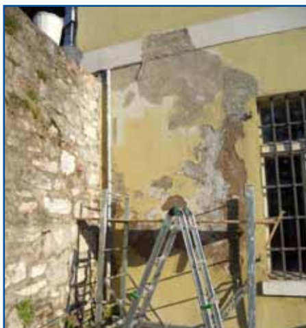
Laste - Dei volontari danno una mano a intonacare una parete malandata della casa dei Frati
