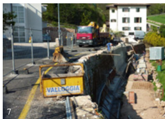
Foto 7: Terminati i lavori su via alle Coste, anche con il ripristino del manto stradale
