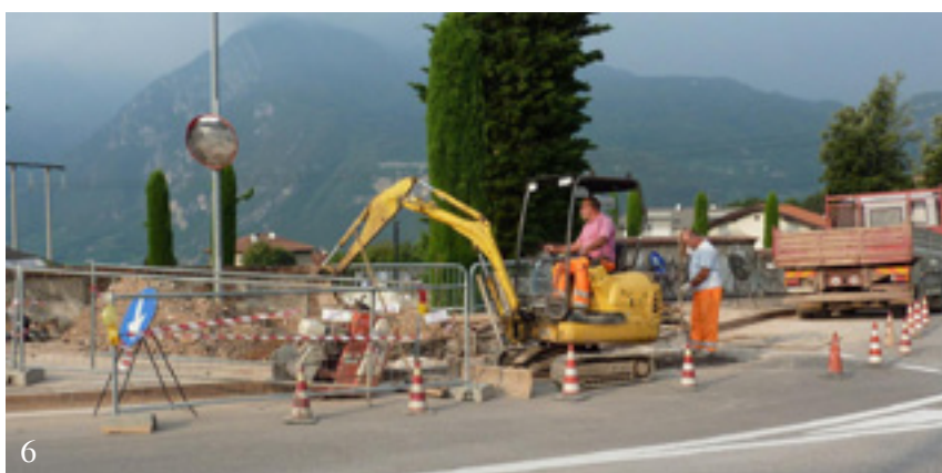
Foto 6: Sistemazione delle tubazioni davanti al cimitero di Cognola
