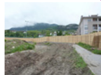
30/05/2013 - Viene avviato il secondo cantiere ITEA tra il Centro Civico di Cognola e il campo da calcio Marnighe.
