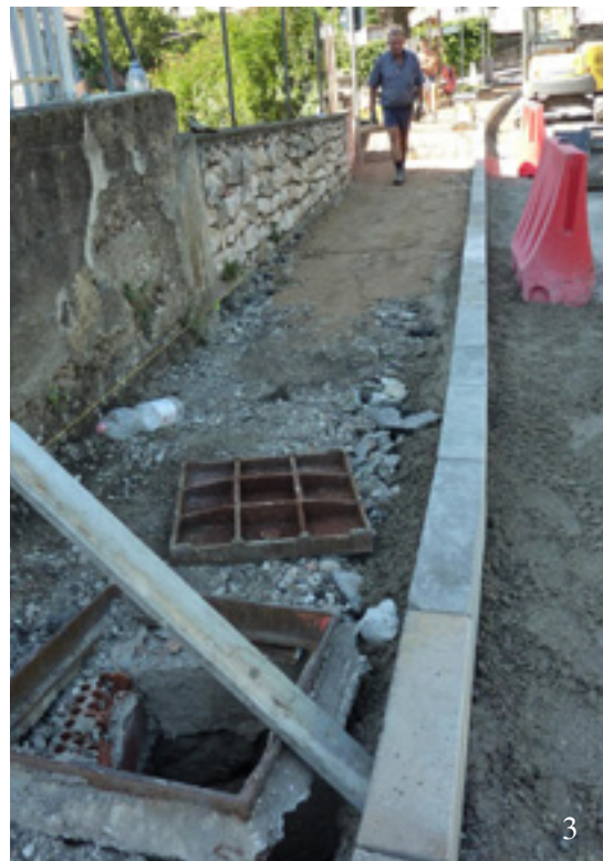
Foto 3: Cognola. Rifacimento di tombini e relativo marciapiede in via Ponte Alto
