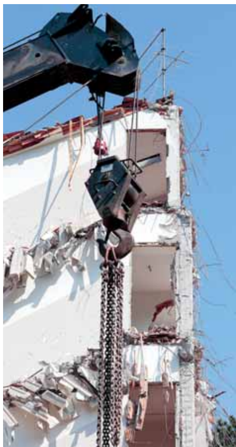
Demolizione palafitte (foto Simonetti)
