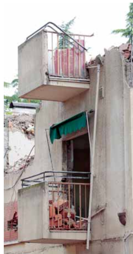
Demolizione palafitte (foto Simonetti)
