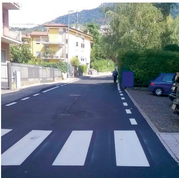
Via Chini asfaltata
