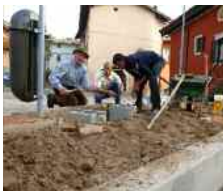
Oreste Chemelli predispose i pozzetti con due volontari
