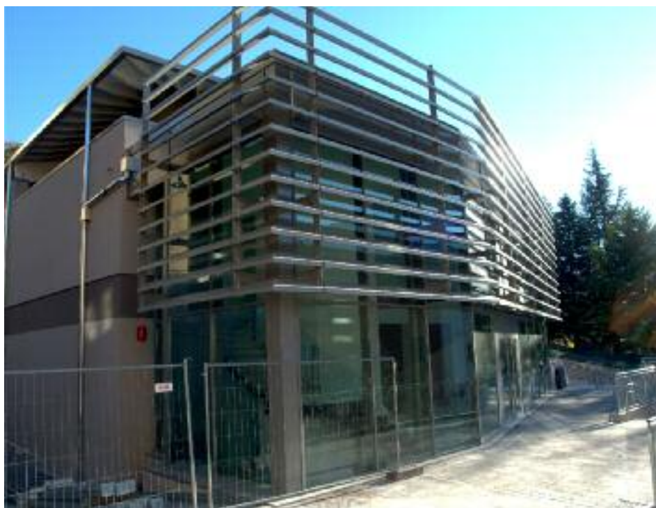
La facciata del teatro in costruzione
