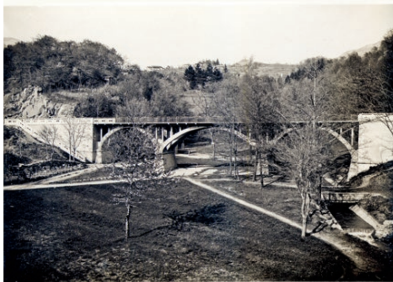
Strada della Fricca. Viadotto di Gocciadoro presso Trento "Per gentile concessione del signor Roberto Gamberoni"
