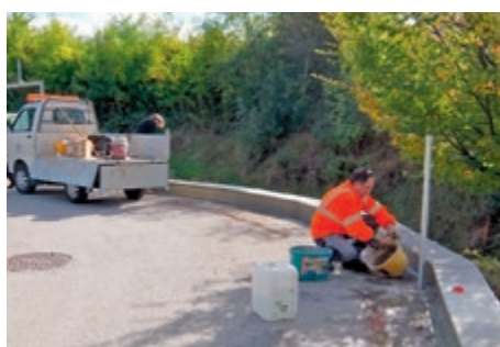
20.10.2016 Gli operai comunali sistemano le coperture dei muretti al parco di Martignano.
