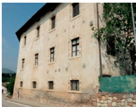
11.04.2016 Vengono finalmente tolti i ponteggi a Palazzo Travaglia di Cognola.
