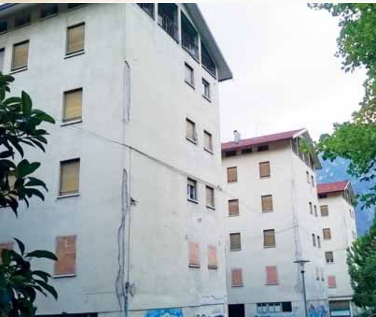
Le ultime palafitte che verranno poi abbattute nel corso del 2014.
