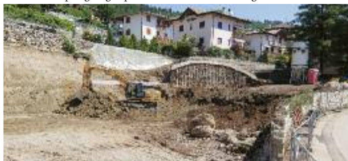
Inizio lavori per garages pertinenziali a Villamontagna
