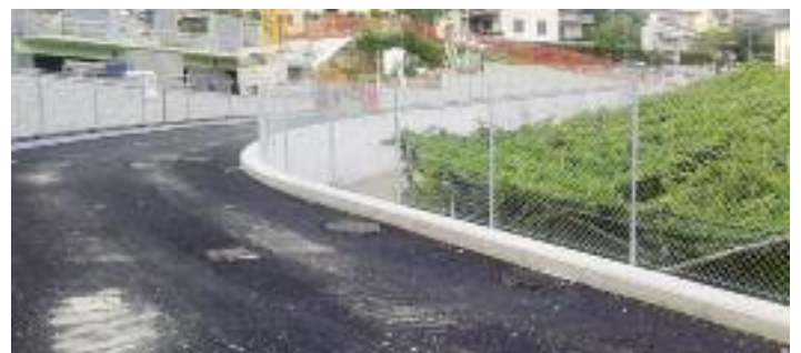
Via delle Laste durante i lavori
