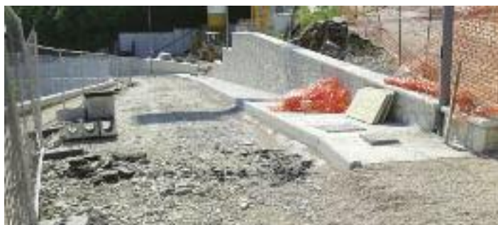
Imbocco Via delle Laste durante i lavori
