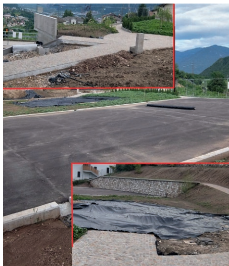
Sono in dirittura d'arrivo i lavori del parcheggio pertinenziale di Villamontagna
