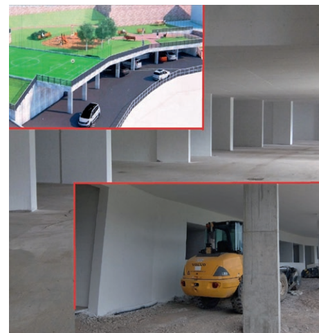
Quasi terminati i lavori. Qui si vedono gli interni e gli esterni dei parcheggi pertinenziali di Villamontagna. In alto il rendering
