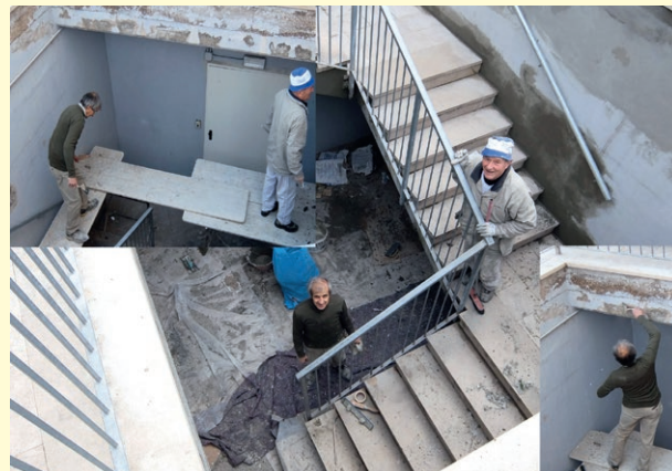
Renato Eccher e Luigi Bottinelli intonacano il vano scala che porta posteggio pubblico
