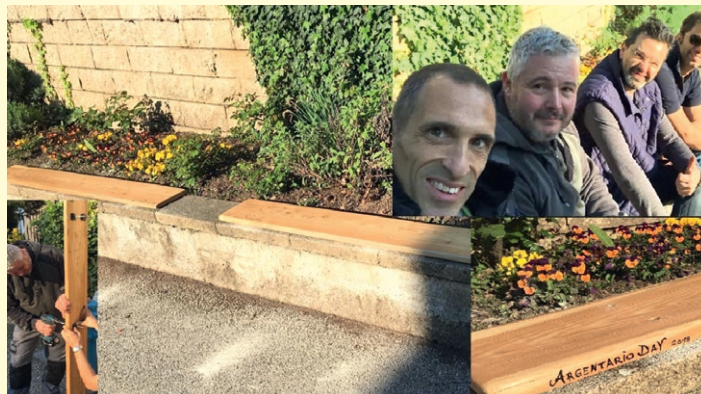
Trasformazioni dei muretti in comodi sentali in legno per chi attende gli alunni fuori dalla scuola elementare di San Vito
