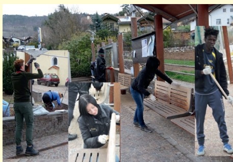
Si carteggiano e tinteleggiano le panchine; si realizzano piccole manutenzioni sul territorio
