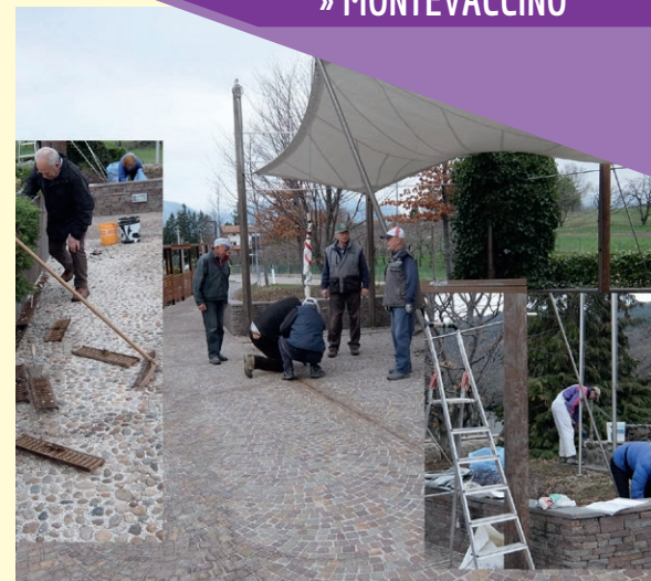
I diversamente... giovani sono a disposizione per pulire le caditoie e fare piccoli interventi di manutenzione
