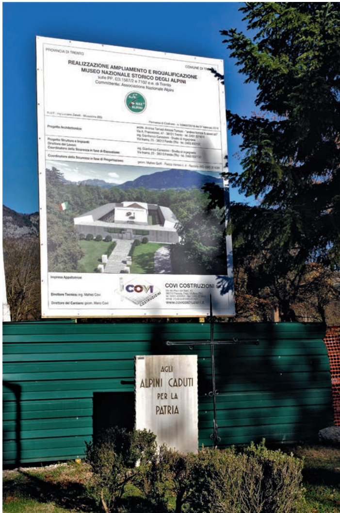
Il cantiere sul Dos Trento
