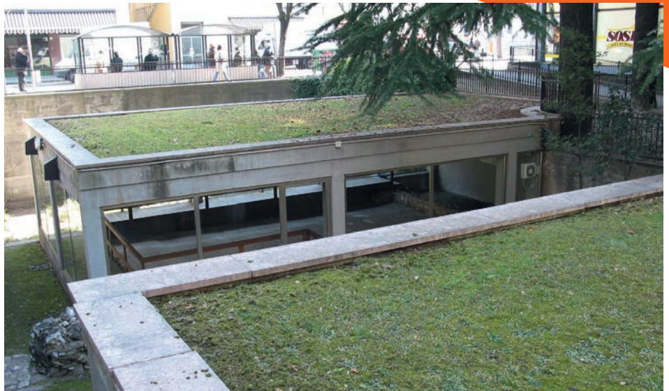
Fig. 2. Trento, via Rosmini – villa romana: la copertura della domus realizzata nel corso degli anni '60 del secolo scorso.
