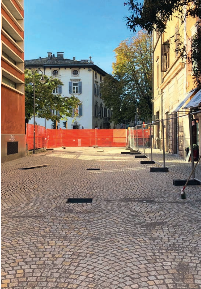
Si stanno ultimando i lavori in via San Martino
