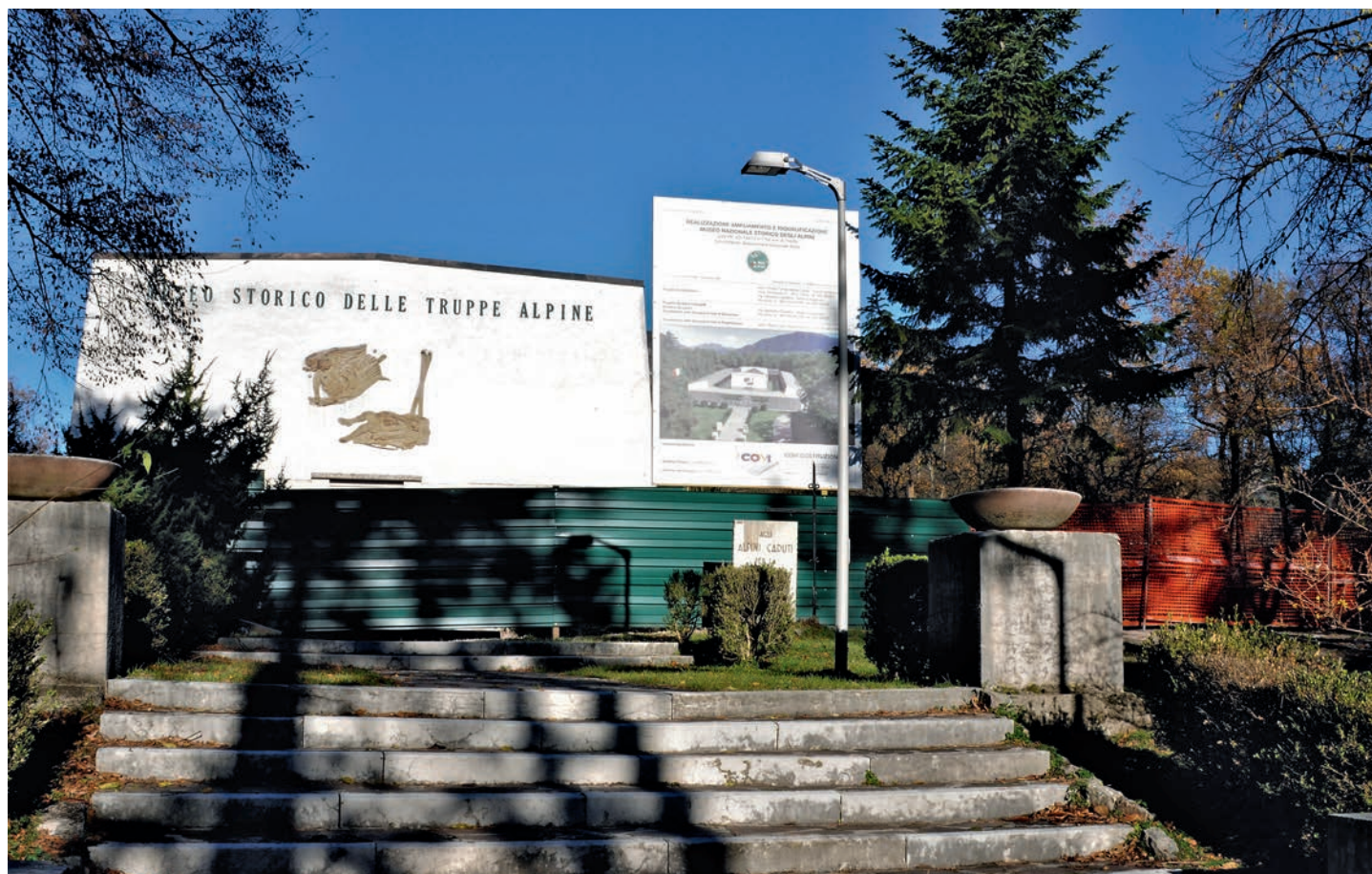
Il cantiere sul Dos Trento
