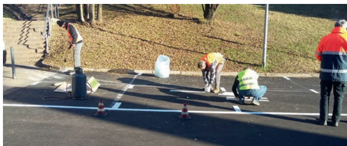
Rifacimento asfaltatura e stalli in Piazzale Europa.
