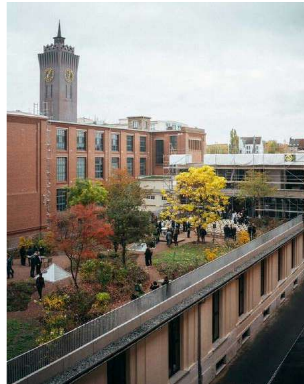
Imm 31 e 32- Wirkbau Chemnitz Roofgarden, Meyer-Grohbrugge, Chemnitz, 2022.
