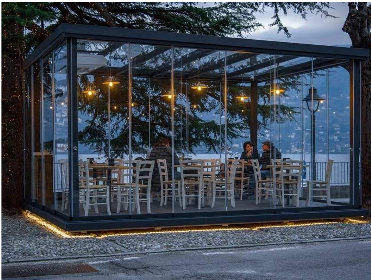
Figura 5- Esempio Dehor con struttura in acciaio, vetrate perimetrali e di copertura
