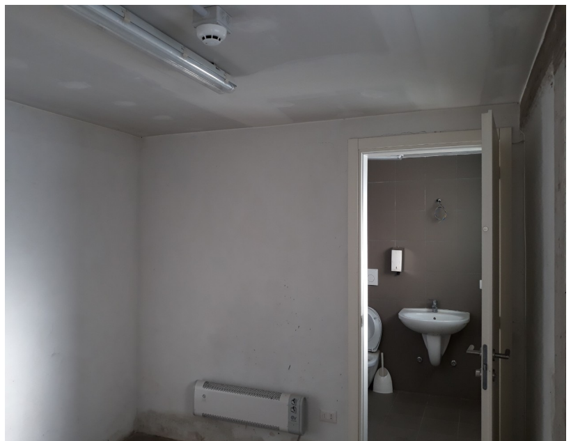
Deposito con annesso wc
