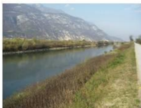
Foto 2.8.5.2 – Manutenzione meccanica lungo gli argini
