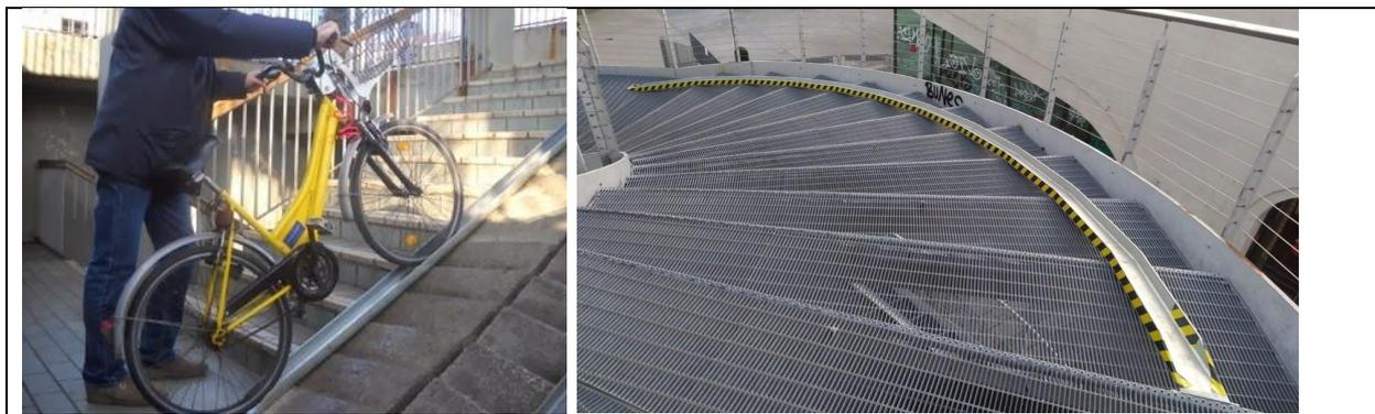
Esempio di canalina per superamento scalinate.
