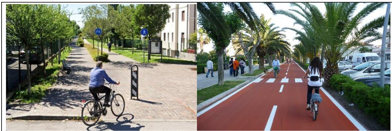
**piste ciclabili su corsia riservata ricavata dalla carreggiata stradale**, ad unico senso di marcia, concorde a quello della contigua corsia destinata ai veicoli a motore ed ubicata di norma in destra rispetto a quest'ultima corsia, qualora l'elemento di separazione sia costituito essenzialmente da striscia di delimitazione longitudinale o da delimitatori di corsia;
