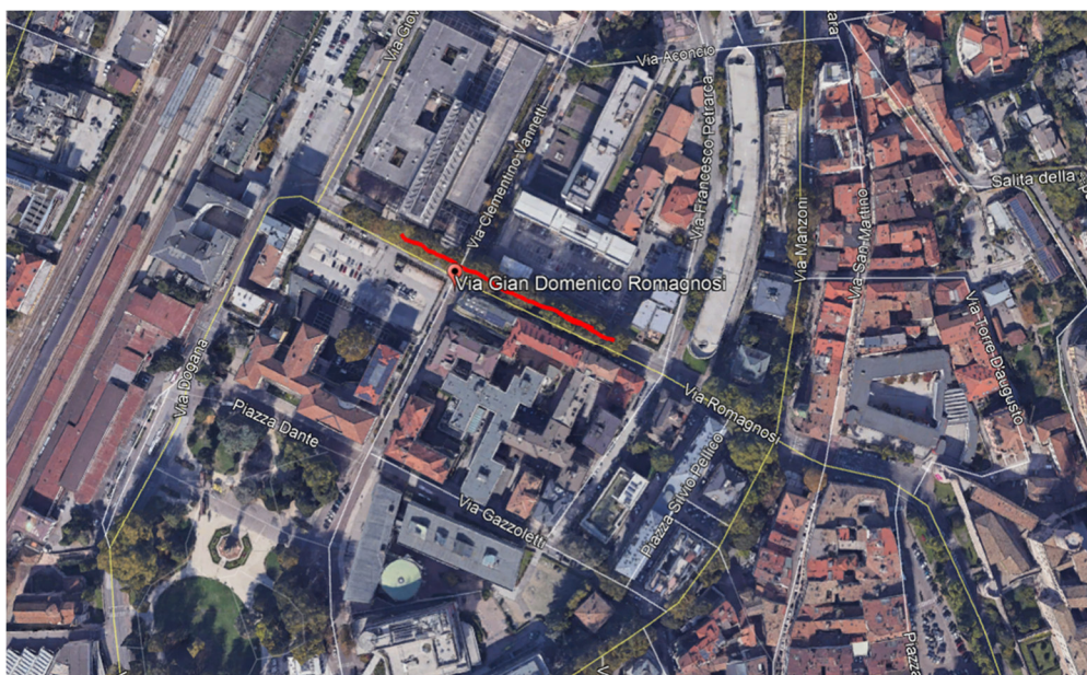
(Pista ciclopedonale in Via di Romagnosi, fonte: Google Earth)
