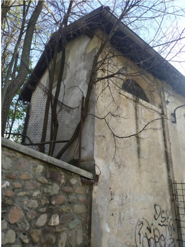
Allegato 2. Foto della struttura allo stato attuale.
