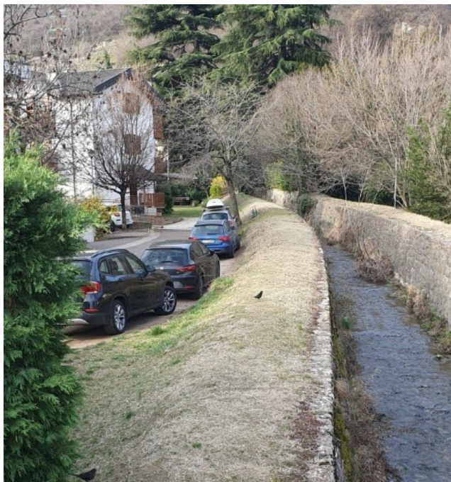
foto 1 – Torrente Vela con argine pubblico
