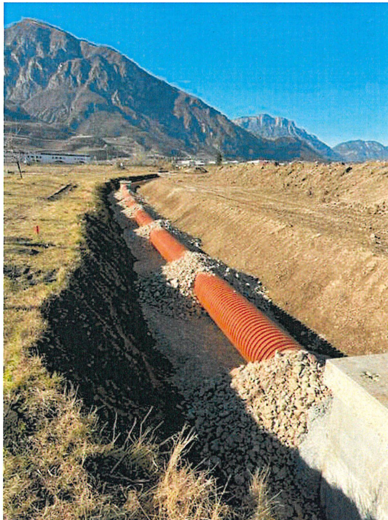
Foto 1: Tubazione posata lungo la Fossa Catena
