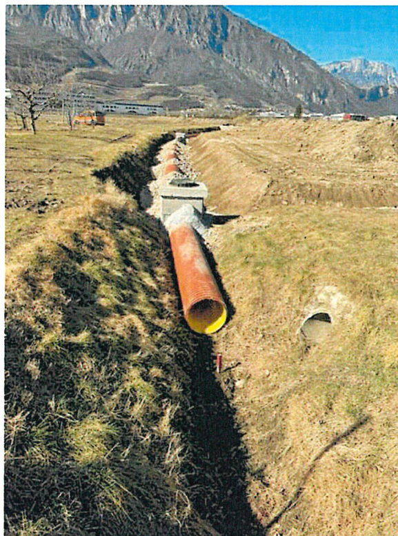
Foto 3: Tubazione di uscita verso sud, a valle del pozzetto di collegamento
