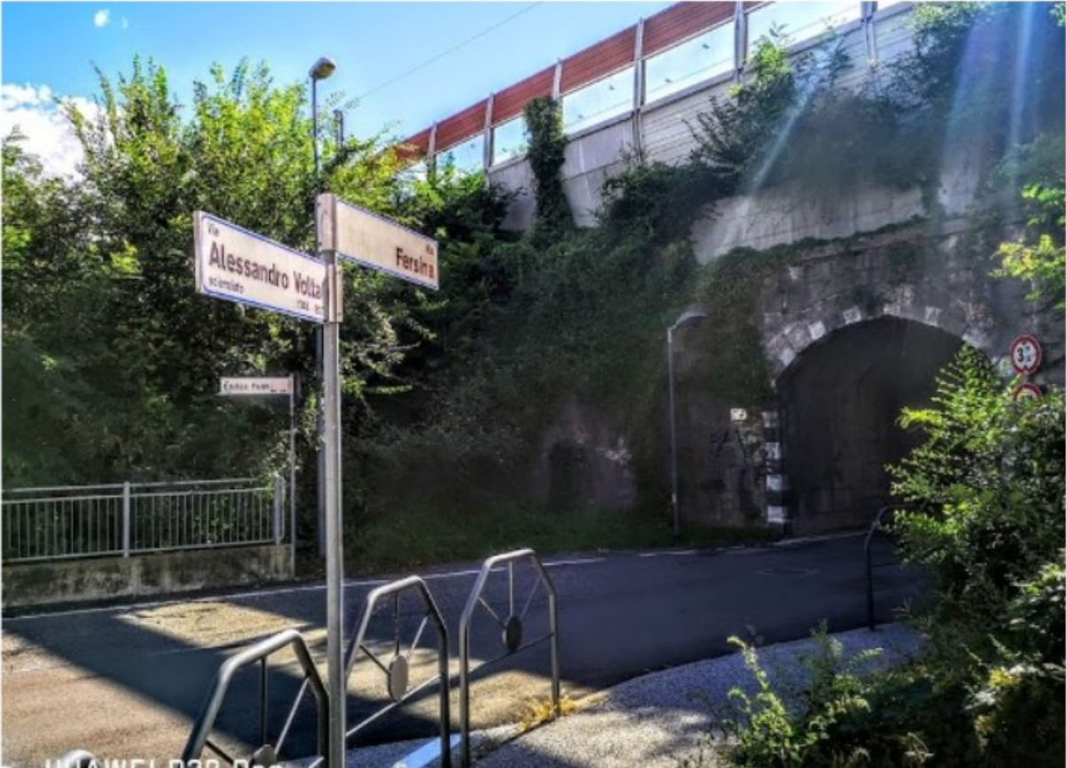
Foto 3 Sottopasso tra via Volta, via Fersina e via Fermi
