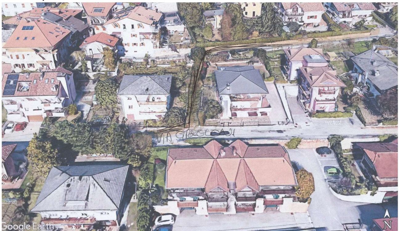
Evidenza in fotografia aerea della strada preesistente e recuperabile con l'interessamento dell'ente pubblico:
