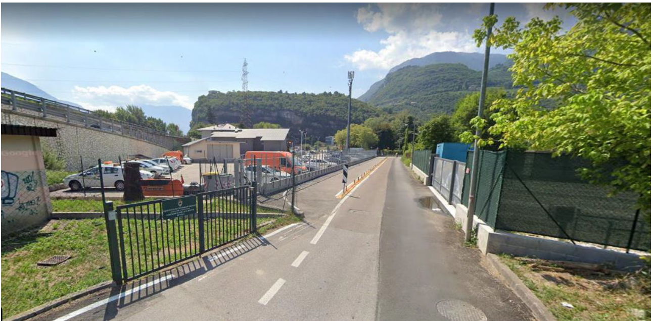
foto 5 - Strettoia generata dalla presenza della rete della stazione di sollevamento
