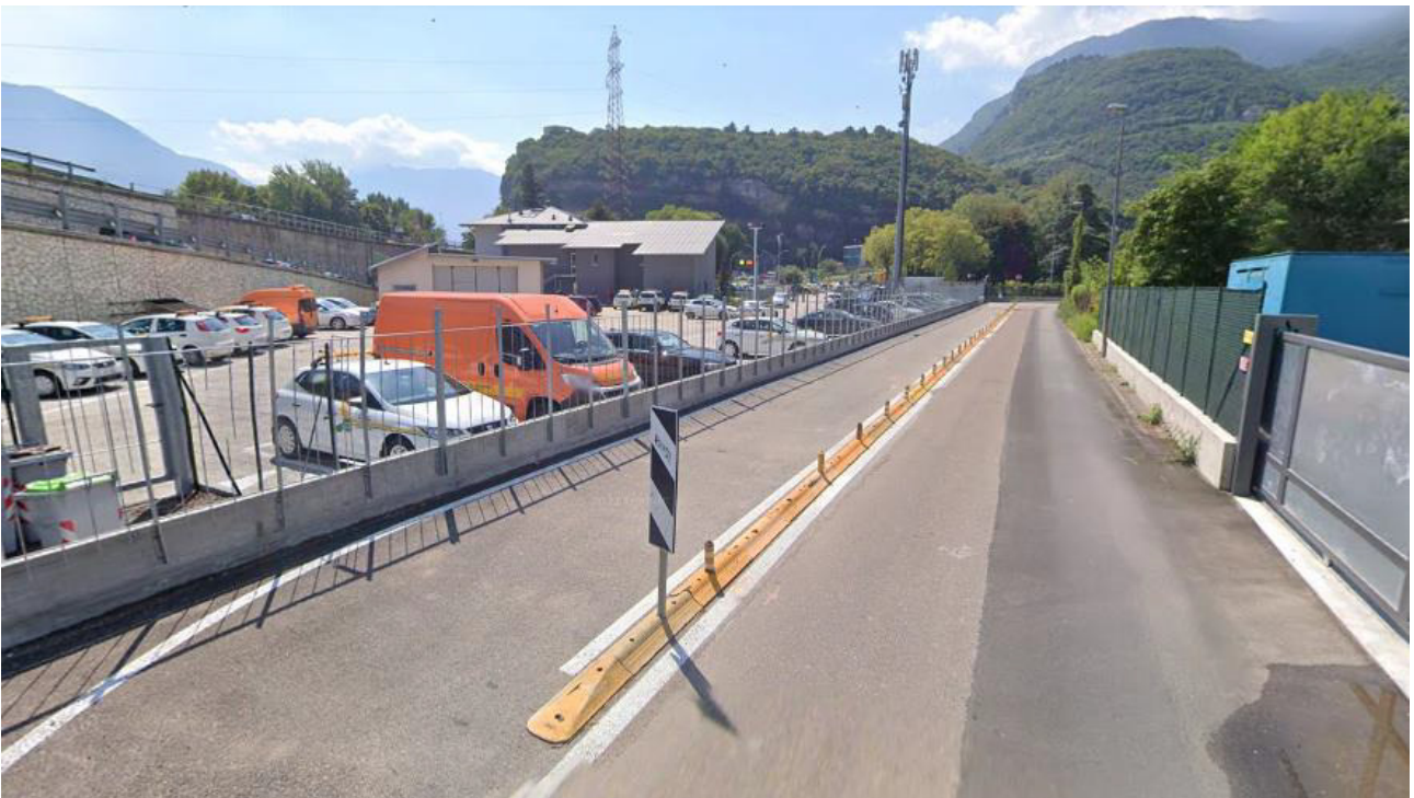
foto 2 - Assenza segnaletica orizzontale ciclopedonale
