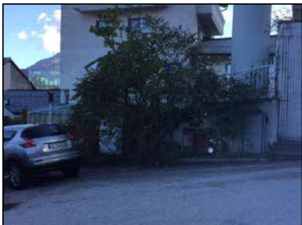
Un'immagine dell'alberatura e della presa danneggiata
