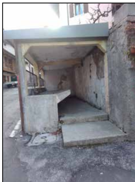
La situazione dell'"interno" della fontana di via Centrale a Ravina
